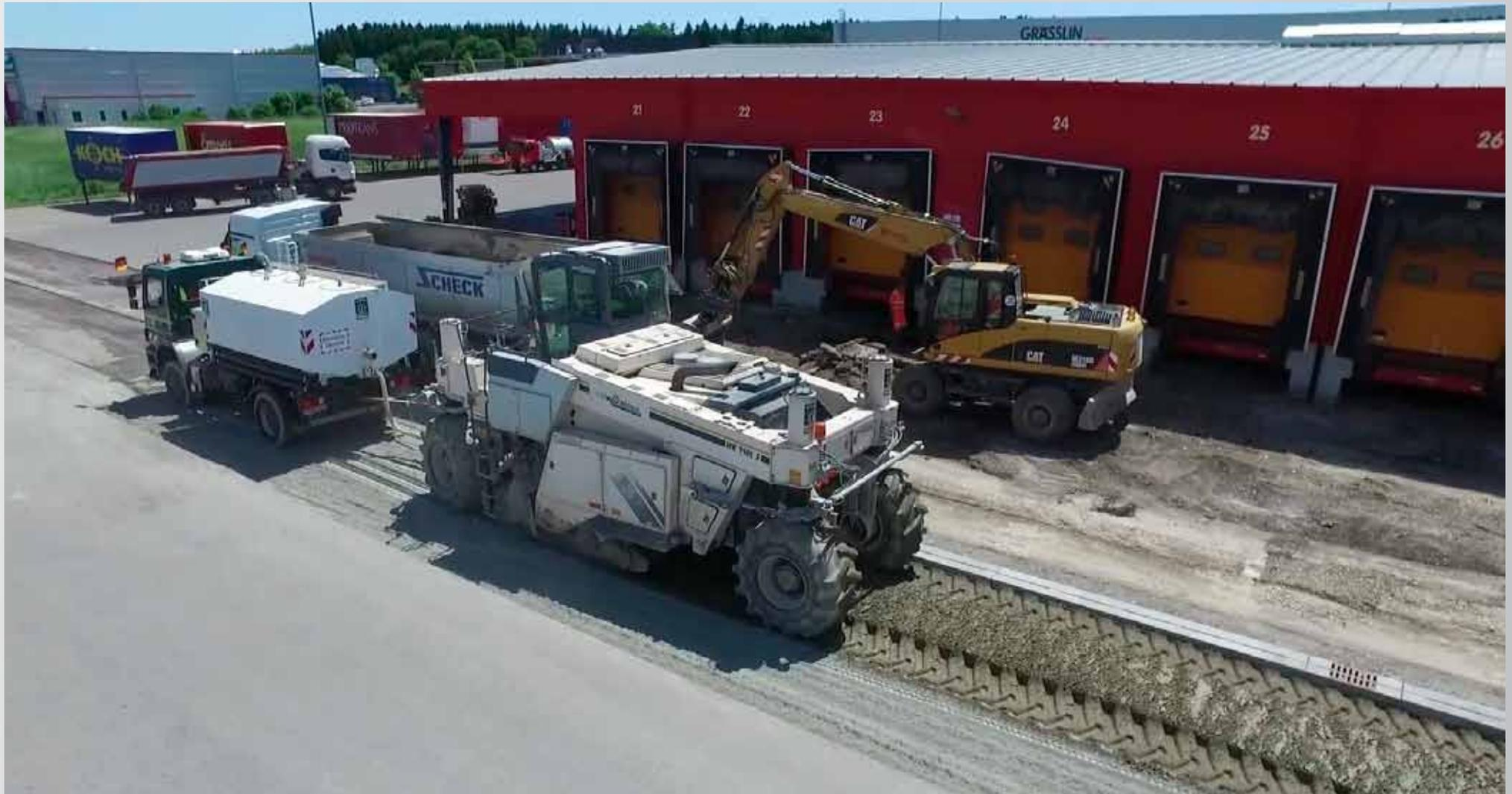
**08.07.2016, 14:02 - Überkorn mittels Steinfräse auf Korngröße 0/45 mm zerkleinern und homogenisieren**
