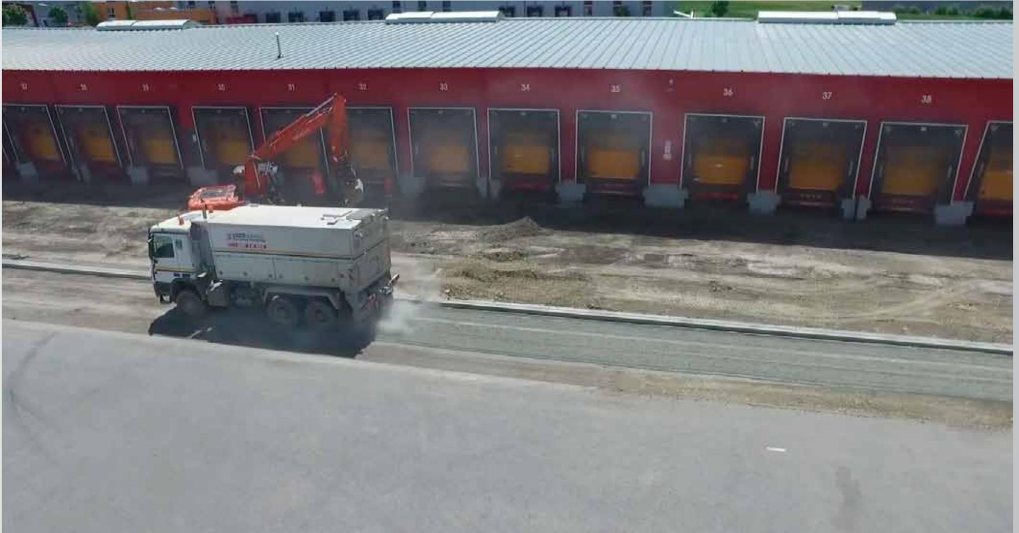
**08.07.2016, 13:42 - NovoCrete-Zement-Gemisch unter mikroprozessorgesteuerter Wasserzugabe homogen einfräsen bis auf eine Frästiefe von 0,45 m**
