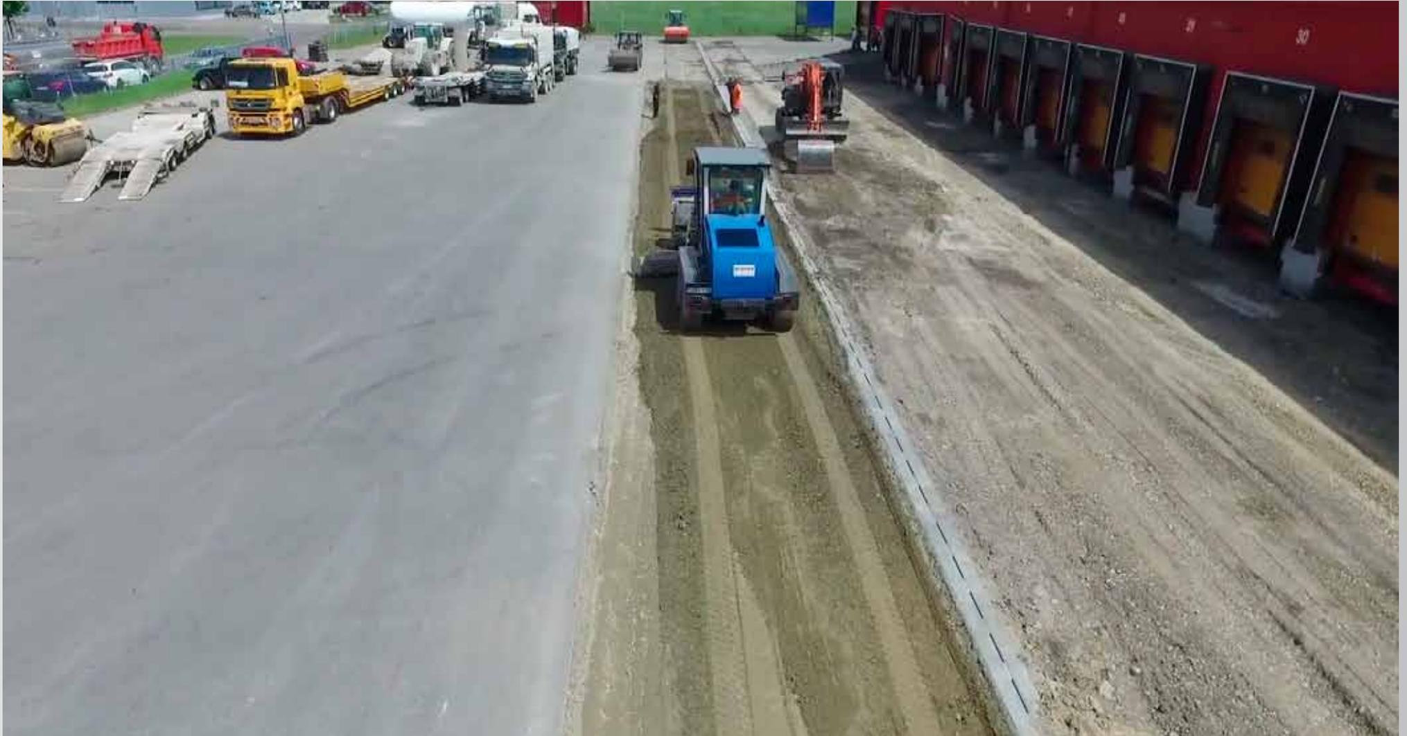
**08.07.2016, 15:05 - Befüllen des Streuers mit dem werkseitig hergestellten Zement-NovoCrete-Gemisch**
