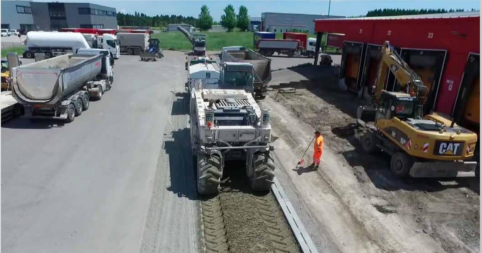
**08.07.2016, 13:43 - NovoCrete-Zement-Gemisch unter mikroprozessorgesteuerter Wasserzugabe homogen einfräsen bis auf eine Frästiefe von 0,45 m**
