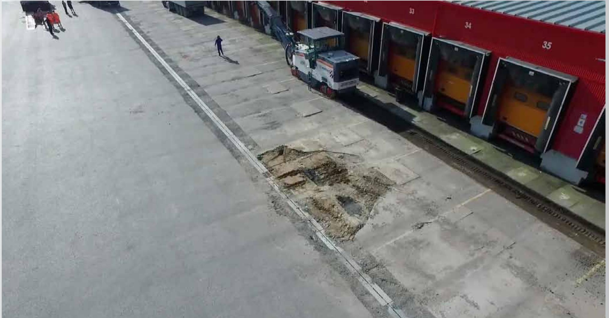
**08.07.2016, 08:39 - Alten Asphalt abfräsen und entsorgen/verwenden**
