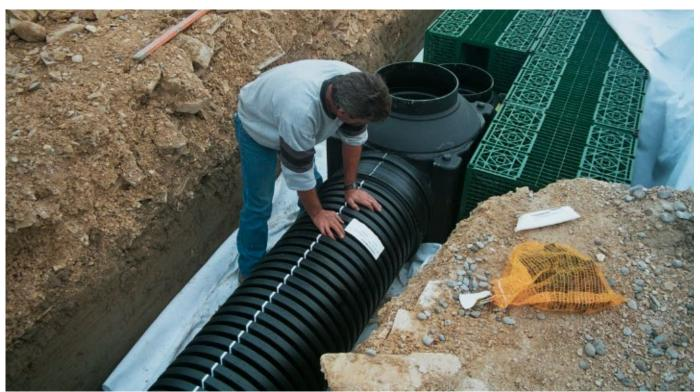
Sedimentationsrohr und Zielschacht mit Anschluss an Füllkörperrigole
