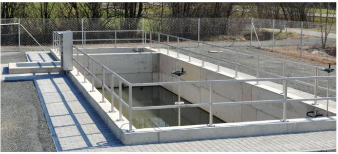
Regenklärbecken in Betonbauweise
