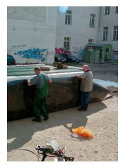
Um Regenwasser als Nutzwasser im Haushalt einsetzen zu können, wird ein RigoCollect-Regenwasserspeicher gebaut. Einer der ersten Schritte ist die Befestigung der Dichtung.
