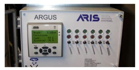
Die Steuerungstechnik wird in Umfang und Ausstattung objektspezifisch an die Erfordernisse angepasst. Pumpen, Armaturen und Filter werden nach Bedarf gesteuert, geregelt und überwacht. Fernüberwachung über eine vorhandene Gebäudeleittechnik ist ebenso möglich wie ein Zugriff über das Telefonnetz oder Internet.
