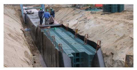
Die geometrische Flexibilität ermöglicht die Einpassung der benötigten Volumina auch bei beengten und schwierigen Bauverhältnissen. Beim Bauen im Bestand kann durch ein "Wanderndes Baufeld", bei dem nur ein kleiner Teil der Baugrube jeweils offen ist, die Nutzungsunterbrechung von Verkehrsflächen minimiert werden.
