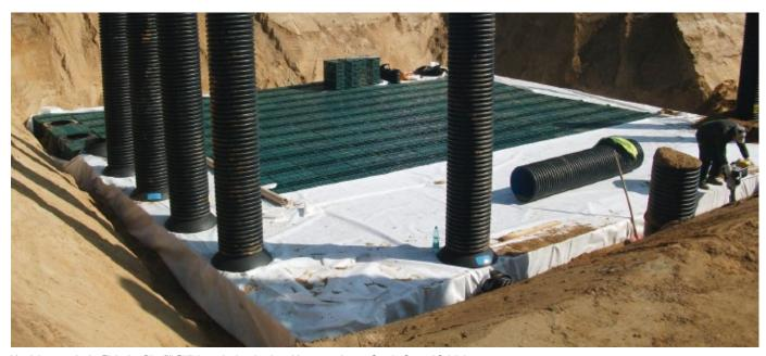
Versickerungsrigole: Einlagige Rigofill-Füllkörperrigole mit stirnseitig angeordneten QuadroControl Schächten
