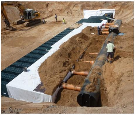
Zweilagige Rigofill-Füllkörperrigole mit Zulaufverteilung
