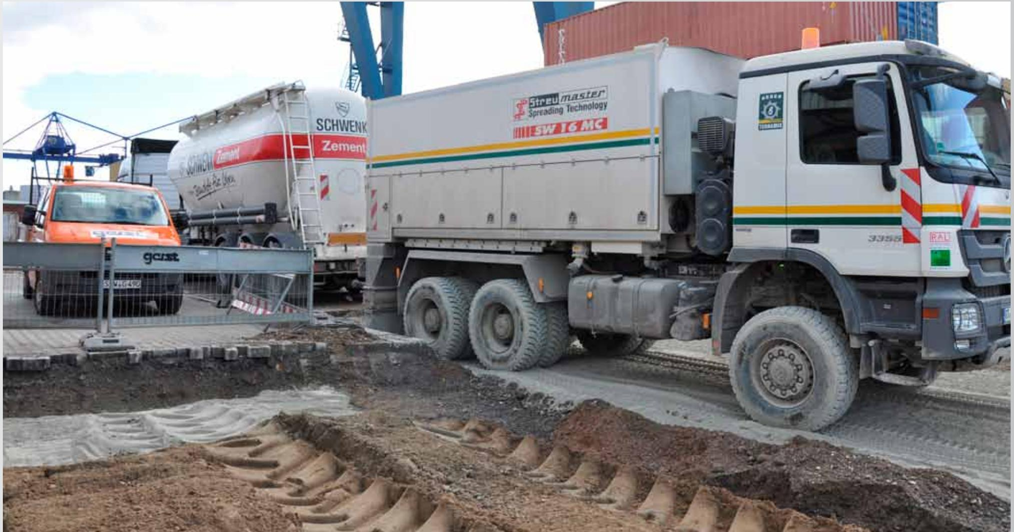
**Ausstreuen der genau definierten Menge (kg) des Zement-NovoCrete-Gemischs pro Quadratmeter (m<sup>2</sup>)**
