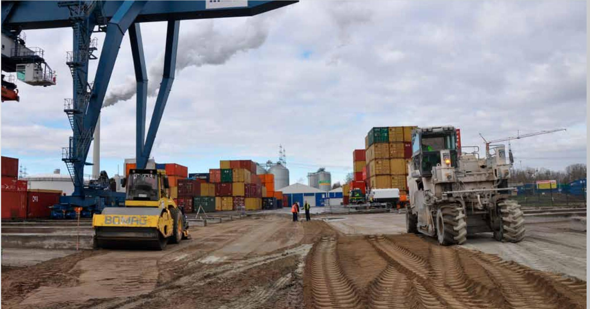
**Planum nach der Verdichtung und anschliessender Bewässerung als Austrocknungsschutz**
