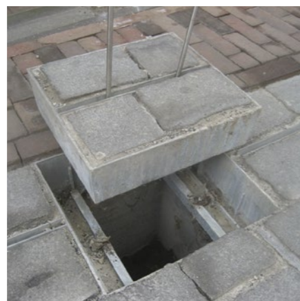
Uitname van een doorspuitpunt met type 1
