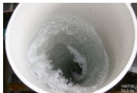
Werveling in de schacht
