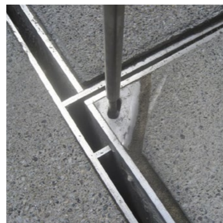
Uitname van een doorspuitpunt met type 2
