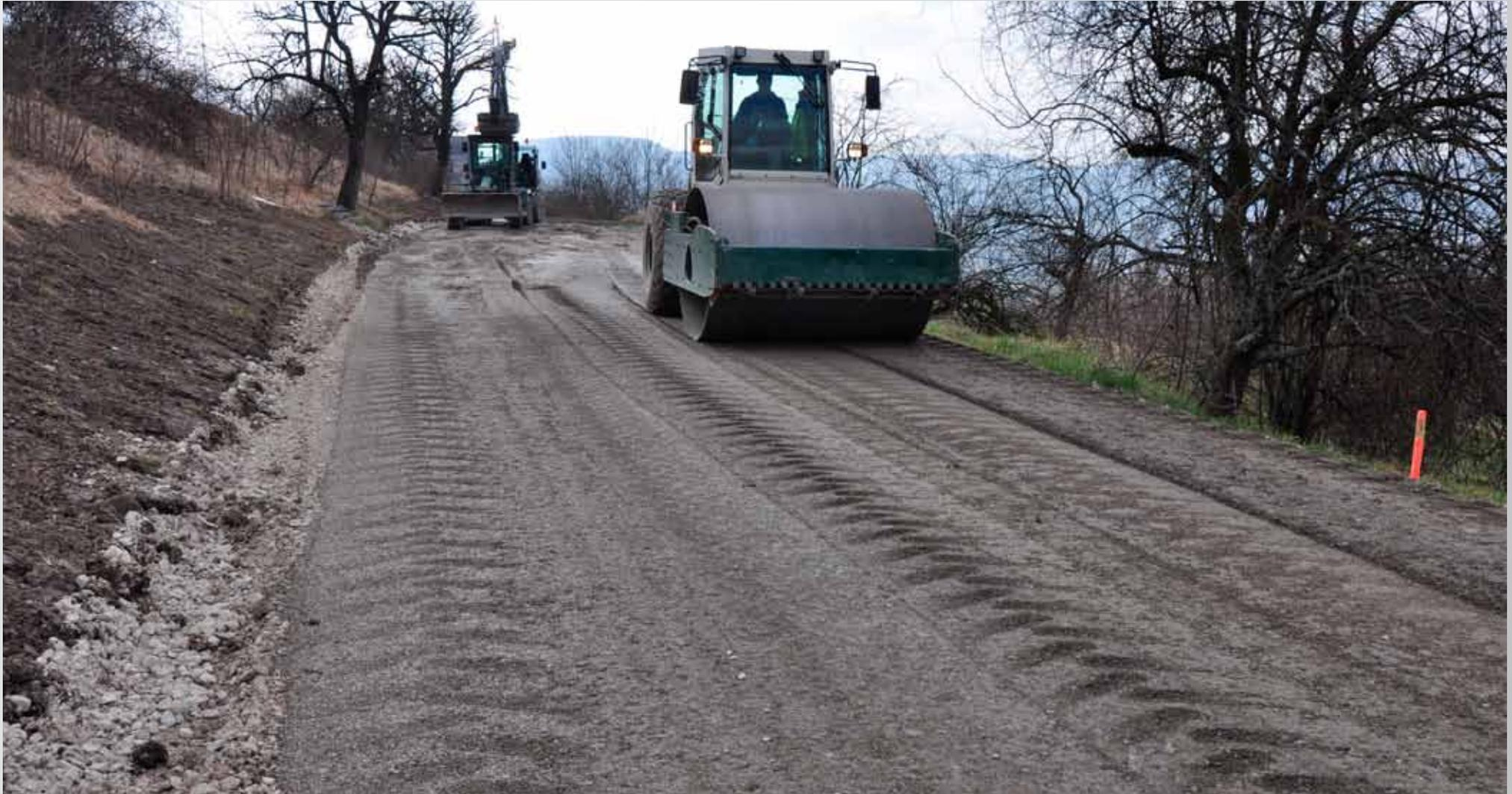
**Levelling des Feinplanums mittels Grader**
