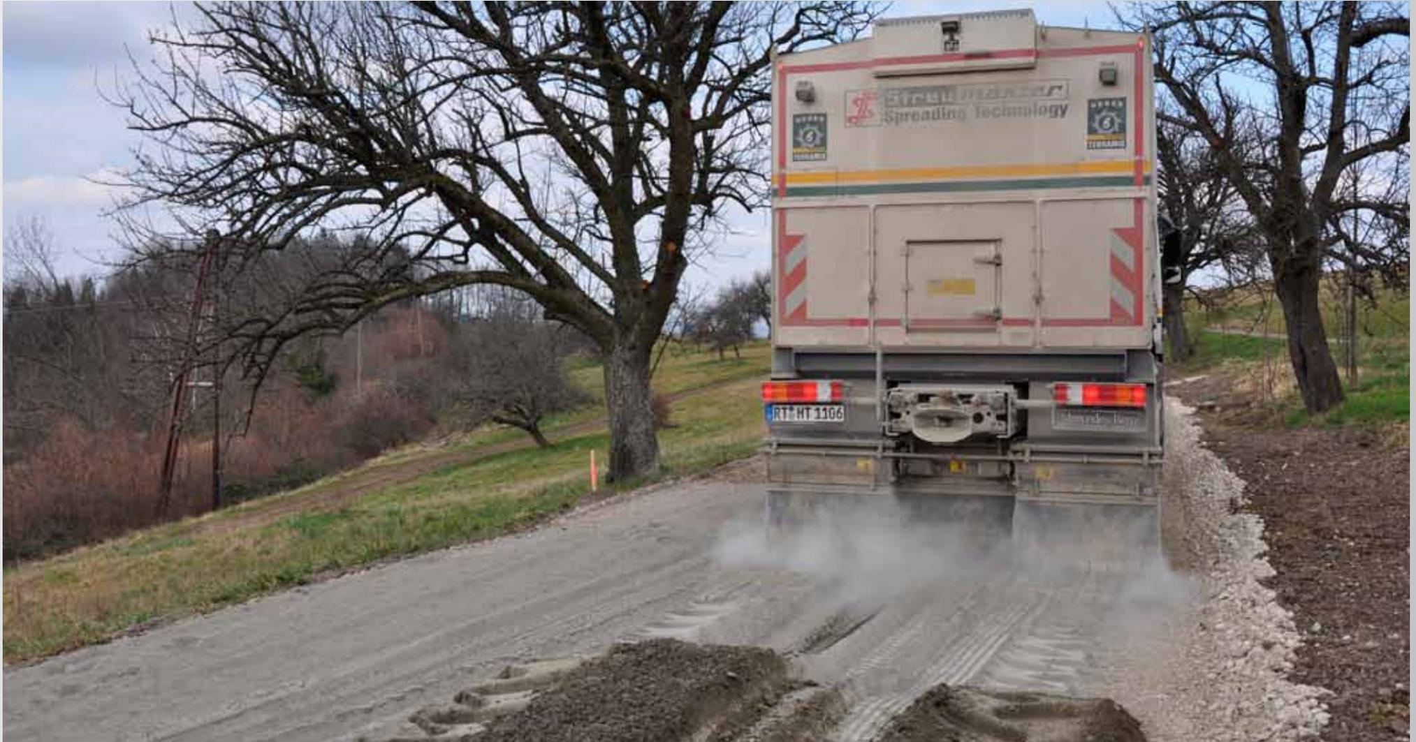
**Einfräsen des Zement-NovoCrete-Gemischs unter Zugabe von Wasser**
