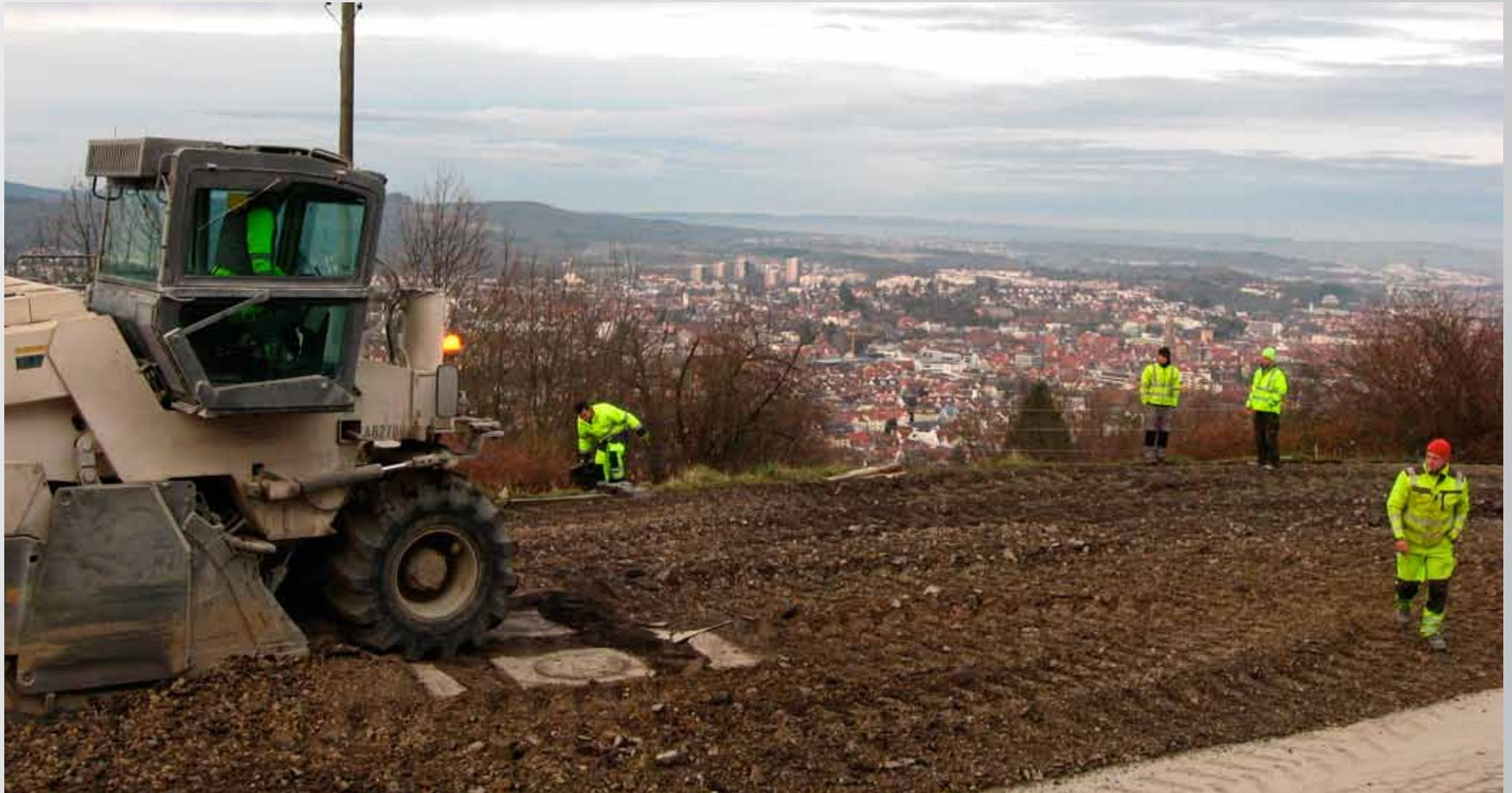
**Zerkleinern des Ausgangsmaterials mit der Steinfräse auf eine Korngrösse < 50 mm**
