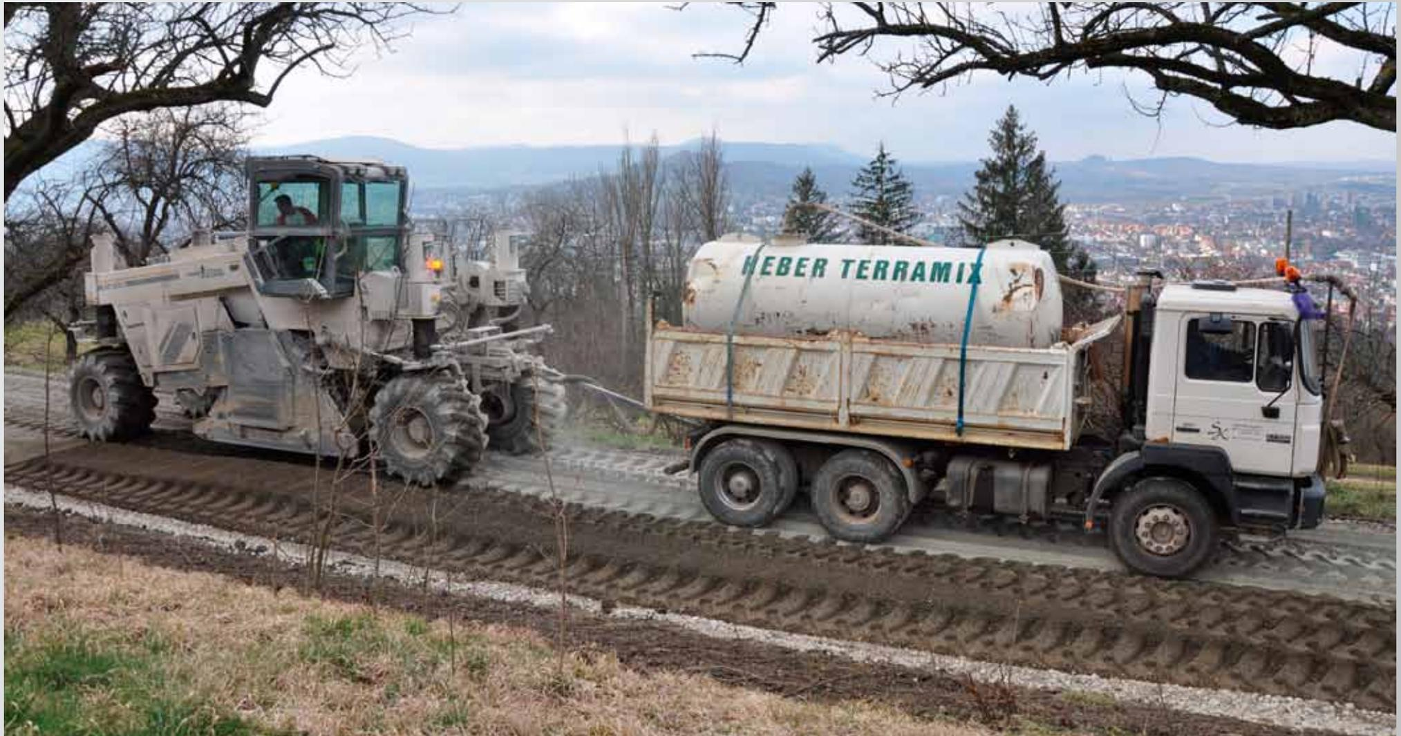
**Einfräsen des Zement-NovoCrete-Gemischs unter Zugabe von Wasser**
