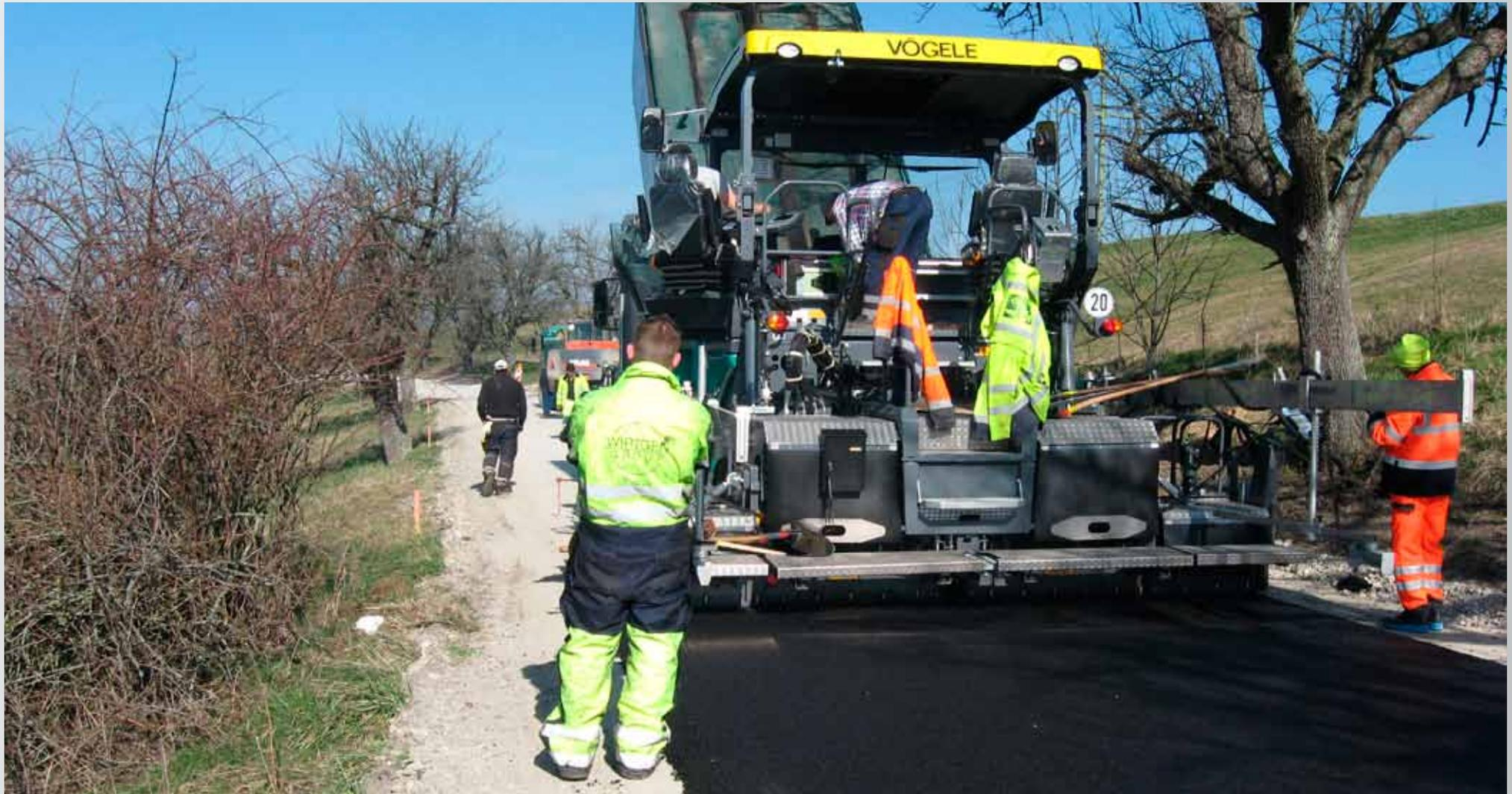
**Einbau des neuen Asphaltbelages**
