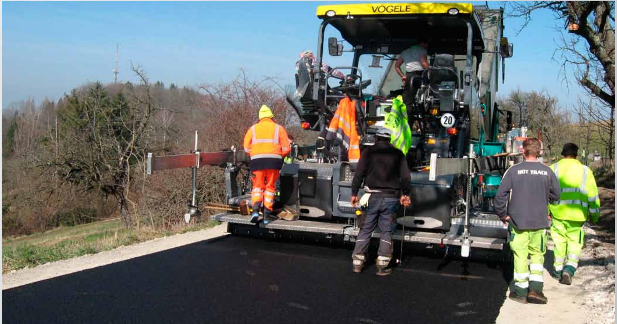
**Einbau des neuen Asphaltbelages**
