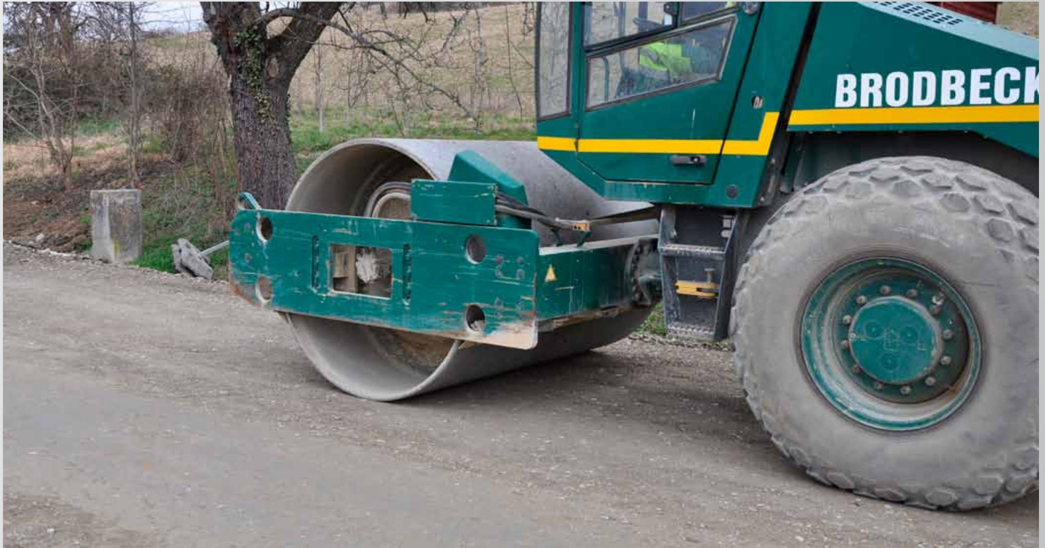
**Einebnen und Verdichten des Feinplanums läuft parallel und in mehreren Arbeitsgängen**
