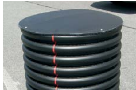
Afdekking van de opzetbuis tijdens de bouwfase.
