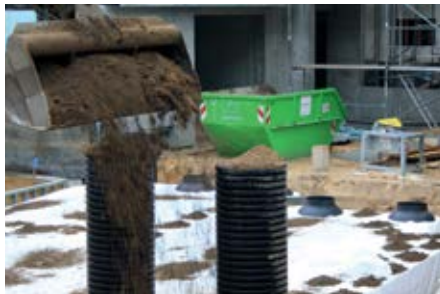
Functie afdekking tijdens de bouwfase bij aanvullen
